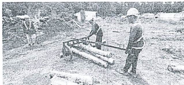
(แบบใหม่) ใช้อุปกรณ์ช่วยยกไม้ท่อนในการคัดแยกขนาดไม้เล็กถึงขนาดกลาง
