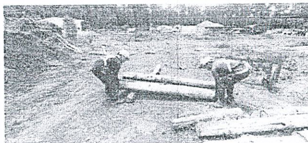
(แบบเดิม) การยกไม้แยกขนาดไม้โดยใช้แรงงานคน
