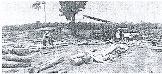
(แบบเดิม) การยกไม้แยกขนาดไม้โดยใช้รถเครนและแรงงานคน
