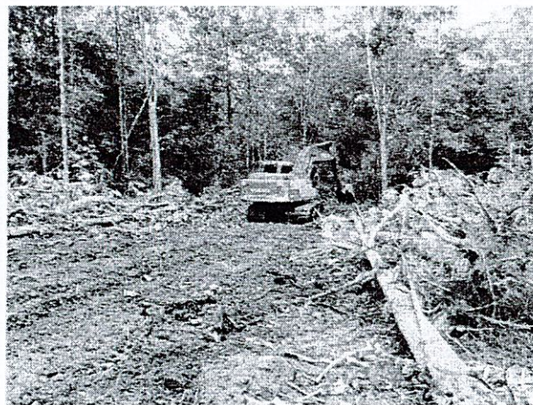
ภาพประกอบที่ ๑ ใช้รถแบคโฮหรือรถแทรกเตอร์ดินตะขบเจาะเส้นทาง
